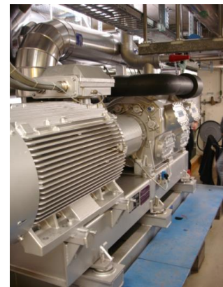
Wärmepumpe zur Abwärmenutzung
